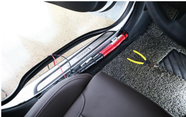
5-5. 앞좌석 및 뒷좌석의 도어 하단에 고무물딩과 도어 실 트림을 분리하고 순경 배선라인에 전원 선을 케이블 타이로 묶어 배선 정리.
